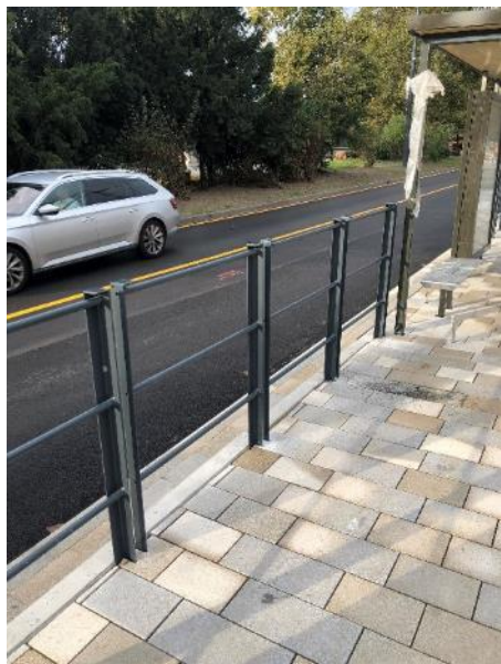
Obrázok 70_Příklad kotvení zábradlí pod povrchem dlažby
