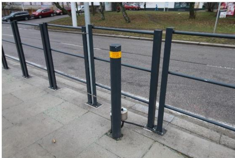
Obrázok 99_Príklad majáčka a nežiadúce riešenie ukoľajnenia
